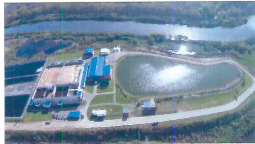
Planta de tratamiento de líquidos lixiviados, Norte III.
